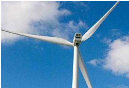
Culminant à 55 mètres, deux nouvelles éoliennes d'une puissance de 900 kilowatts sont venues s'ajouter à celle construite il y a huit ans. Le diamètre de leurs hélices est de 44 mètres.
